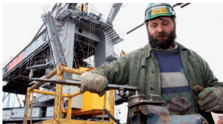
Rekonstrukce rýpadla KU300/19 na montážním místě Marie. Foto SU
