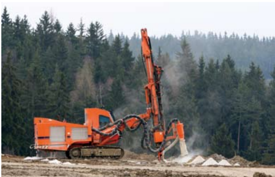
▶ Mezi pomocnou mechanizací patří i speciální vrtné soupravy
