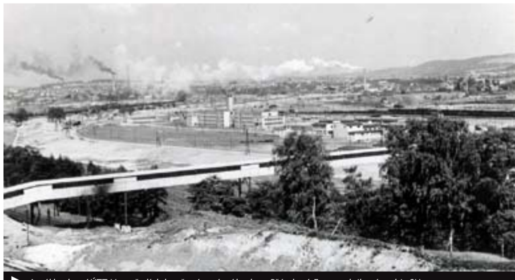
► Areál budoucí ÚTT. V popředí dokončená správní budova Přátelství. Foto podnikový archiv SU
