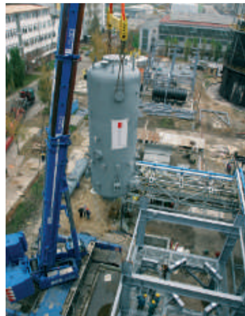
Instalování spalovací komory generátoru ve Vřesové bylo technicky velmi náročné.
