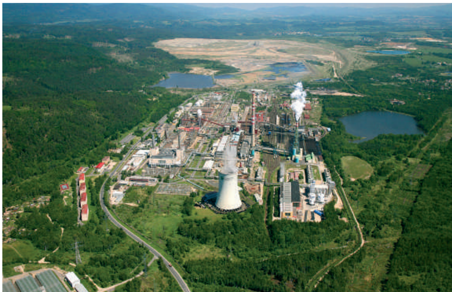
Letecký snímek zpracovatelské části ve Vřesové. V popředí paroplynová elektrárna
