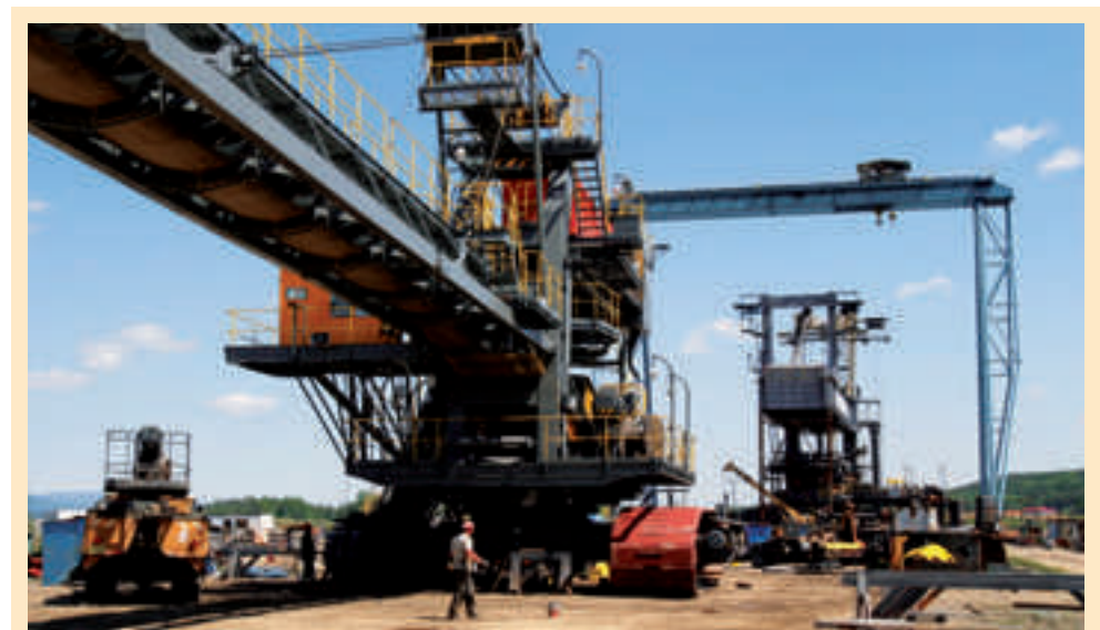
Opravený výložník rýpadla na montážním místě u Královského Poříčí
