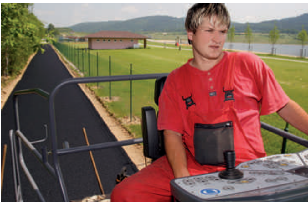
Pokládání povrchu nové cyklostezky kolem nádrže Michal
