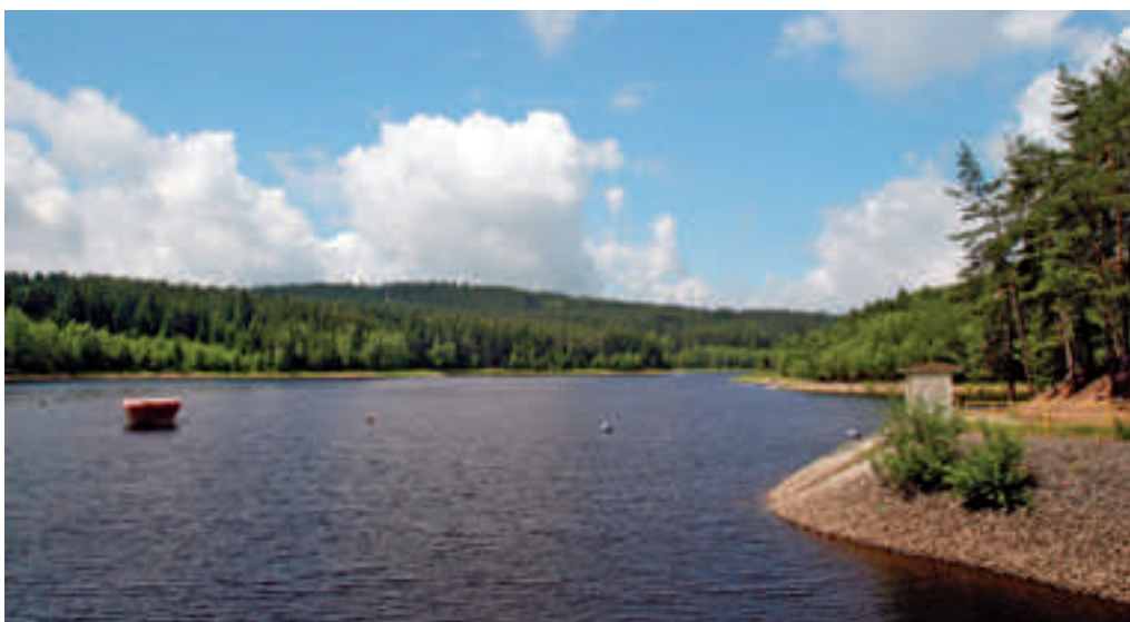
Nádrž v Tatrovicích, vybudována v 60. letech 20. století, zadržuje kolem 1,5 milionu kubíků vody (foto SU)
