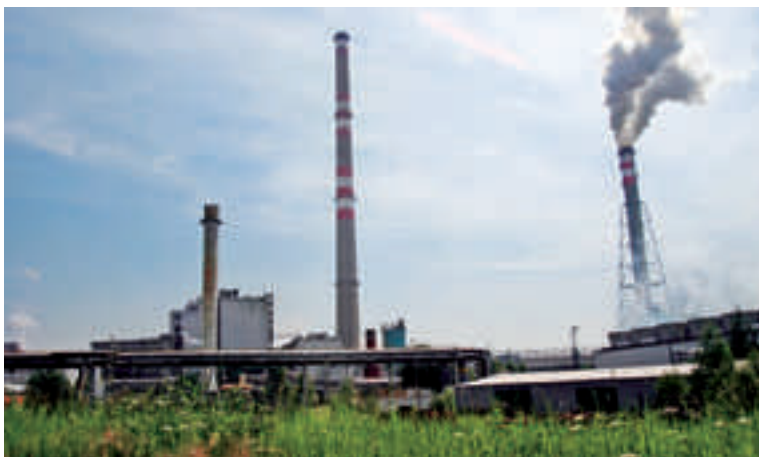
Rekonstrukce bude provedena, aniž by došlo k přerušení výroby elektrické energie nebo tepla (foto SU)
