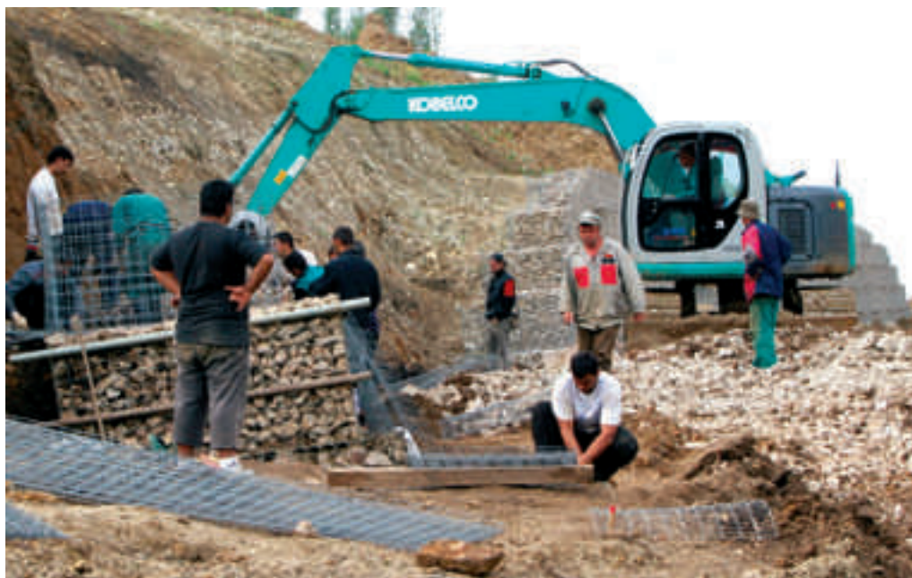
Stavba jedné z částí nového obchvatu
