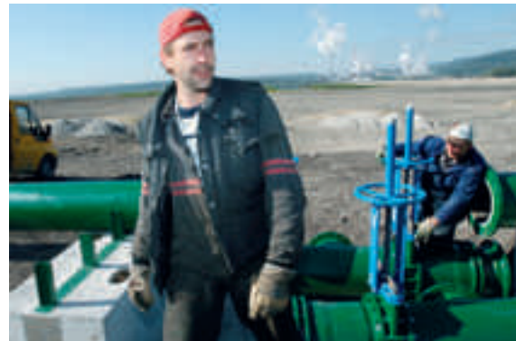
Speciální potrubí s čedičovou vložkou bude už za pár měsíců přivádět do nové kazety ke zpracování škváru z generátoroven a teplárny (foto SU)
