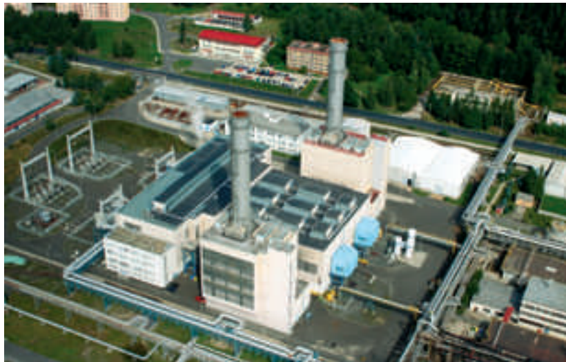
Paroplynová elektrárna společnosti Sokolovská uhelná ve Vřesové (foto SU)
