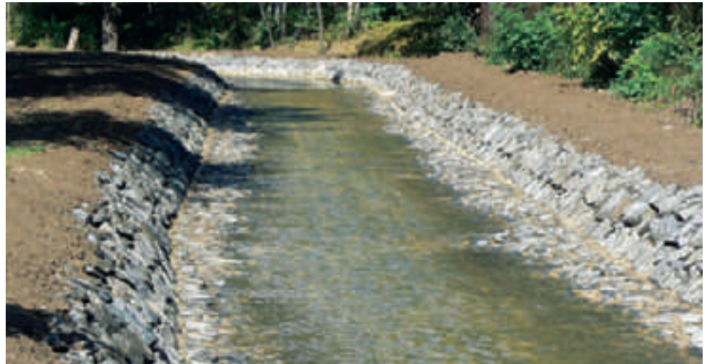
K realizovaným projektům patří i revitalizace Vintířovského potoka
