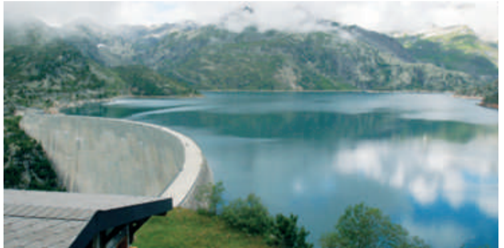
Pohled od stanice lanovky na hráz alpské přehrady Lac d'Emosson (foto Vladislav Podracký)
